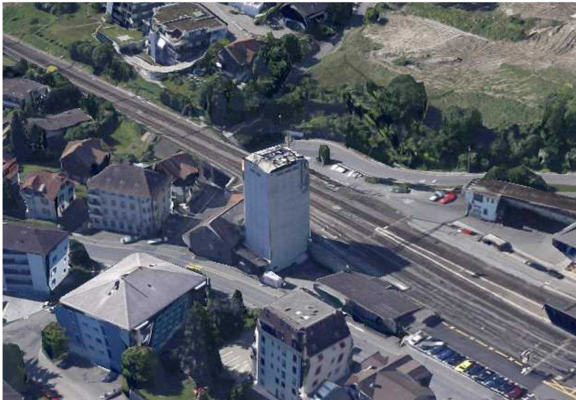
Oberdorfstrasse Horgen, Blickrichtung Süden, Quelle: Google Earth
