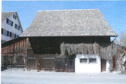
Dorfstrasse 100, Ansicht Scheune von Südosten, 24.03.2010
