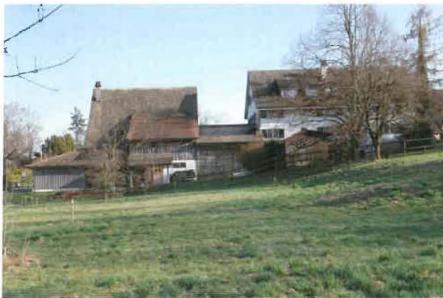
Dorfstrasse 100, Übersicht von Nordwesten, 24.03.2010
