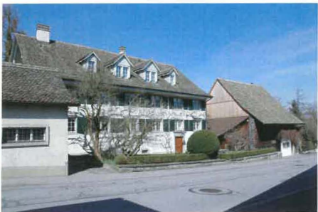
Dorfstrasse 100, Ansicht von Süden, 24.03.2010
