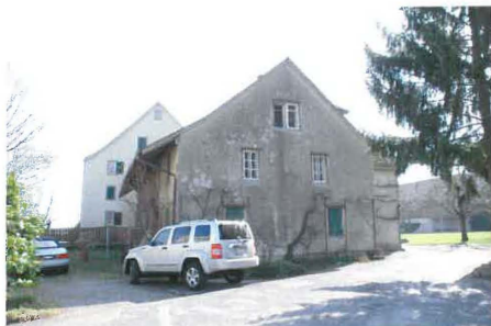
Dorfstrasse 84, Ansicht von Westen, 24.03.2010
