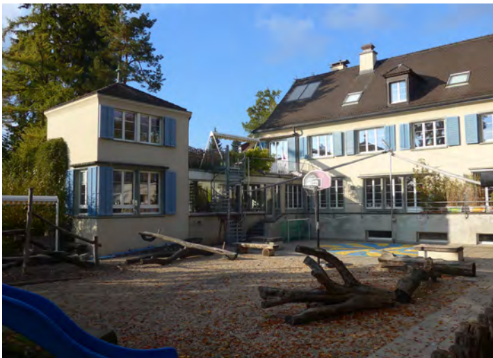
Abb. 8: Blick vom südlichen Pausenbereich zum Hauptgebäude
