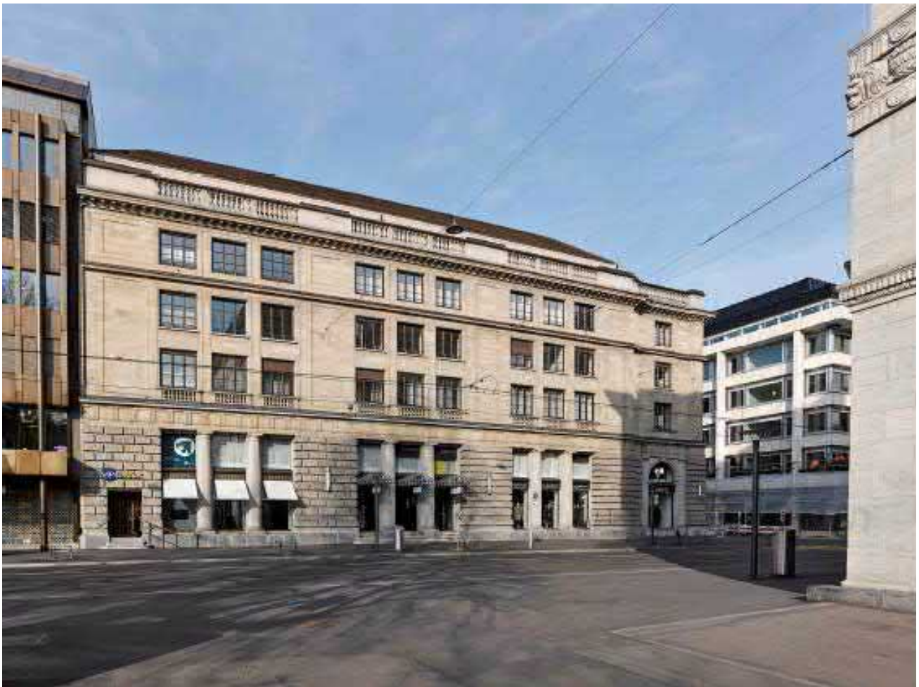
Abbildung 3 Bestehendes Gebäude Seite Bahnhofstrasse
