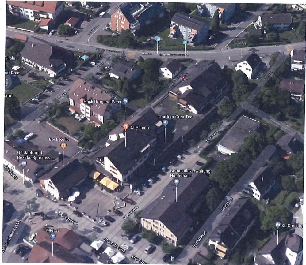
Abbildung 5: Bestehende Bebauung, Blick Richtung Norden (Quelle: Google Maps)
