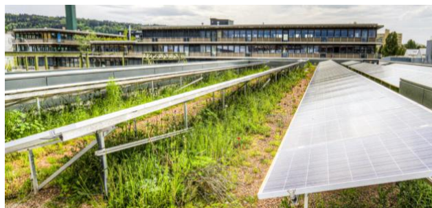
Kombination von Solaranlagen und Dachbegrünung (ewz-Unterwerk Oerlikon, Quelle: ewz)
