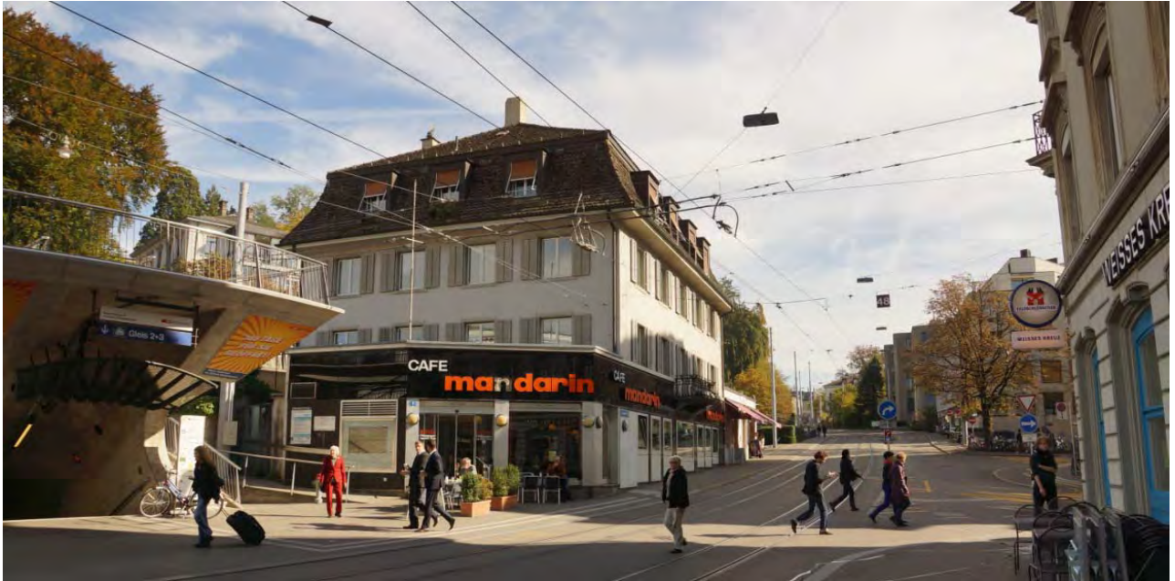
Abbildung 4 Bestandesgebäude – Haus zum Falken (Quelle: Calatrava Valls SA, Zürich)
