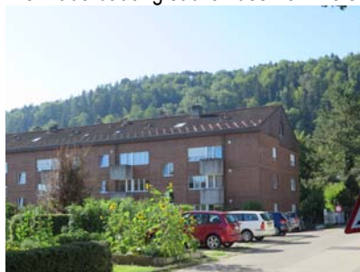
Mehrfamilienhaus südlich des Bahnhofs
