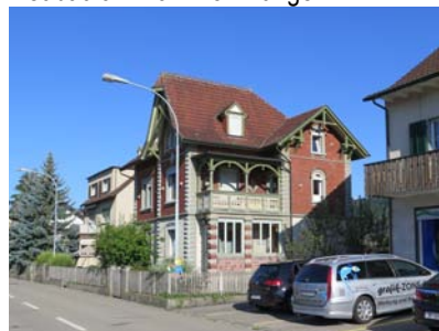
Älterer Wohnbau an der Bahnhofstrasse
