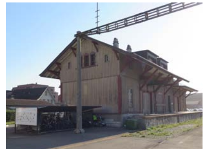
Güterschuppen am Bahnhof Pfungen
