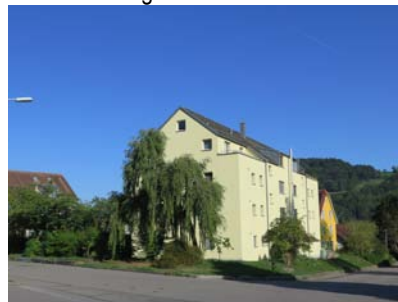
Neubau am Bahnhof Pfungen
