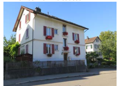
Älterer Wohnbau an der Bahnhofstrasse
