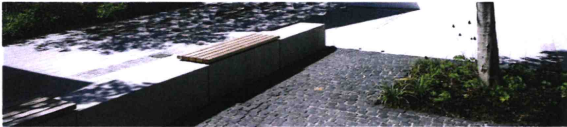
HW-Schutz mittels Sitzelementen mit Holzauflage
