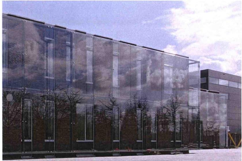
Vor der Fassade ist – wie eine zweite Gebäudehülle – eine Lärmschutzverglasung angebracht, um die Schule von der Hauptstrasse abzuschirmen. Die Fenster können dahinter geöffnet werden, gelten jedoch aus Sicht des Kantons Zürich nicht als eigentliche Lüftungsfenster.
