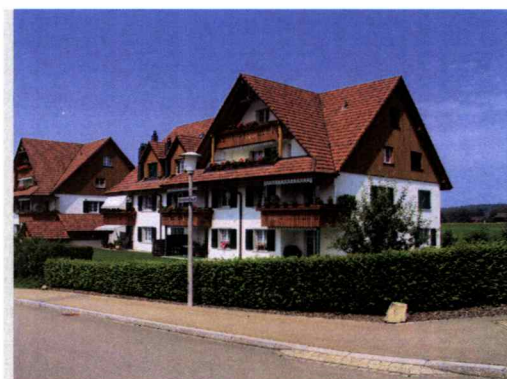
Neubauten an der Bohnackerstrasse. Eine Weiterführung dieser in der Kernzone C entstandenen Bauweise wird nicht als wünschenswert erachtet.
