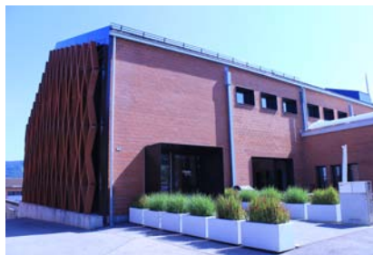
Firmenhauptsitz der Keller-Gruppe in der Ofenhalle
