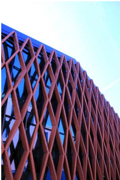
Stirnfassade der Ofenhalle mit ROB-Technik erstellt
