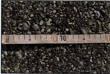
Die Hohlräume im Flüster-Asphalt schlucken viel Lärm.
