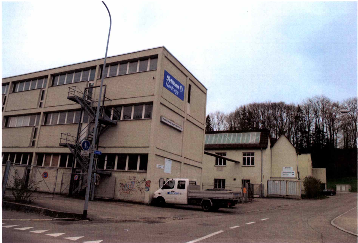
Bau 2 mit dahinterliegendem „Altbau“
