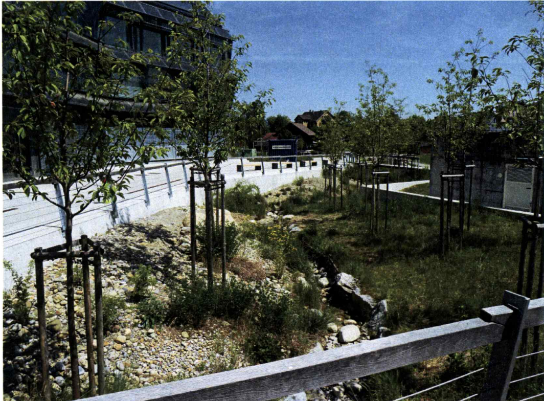
Der im Bereich des Gestaltungsplanes neu gestaltete Vollikerbach
