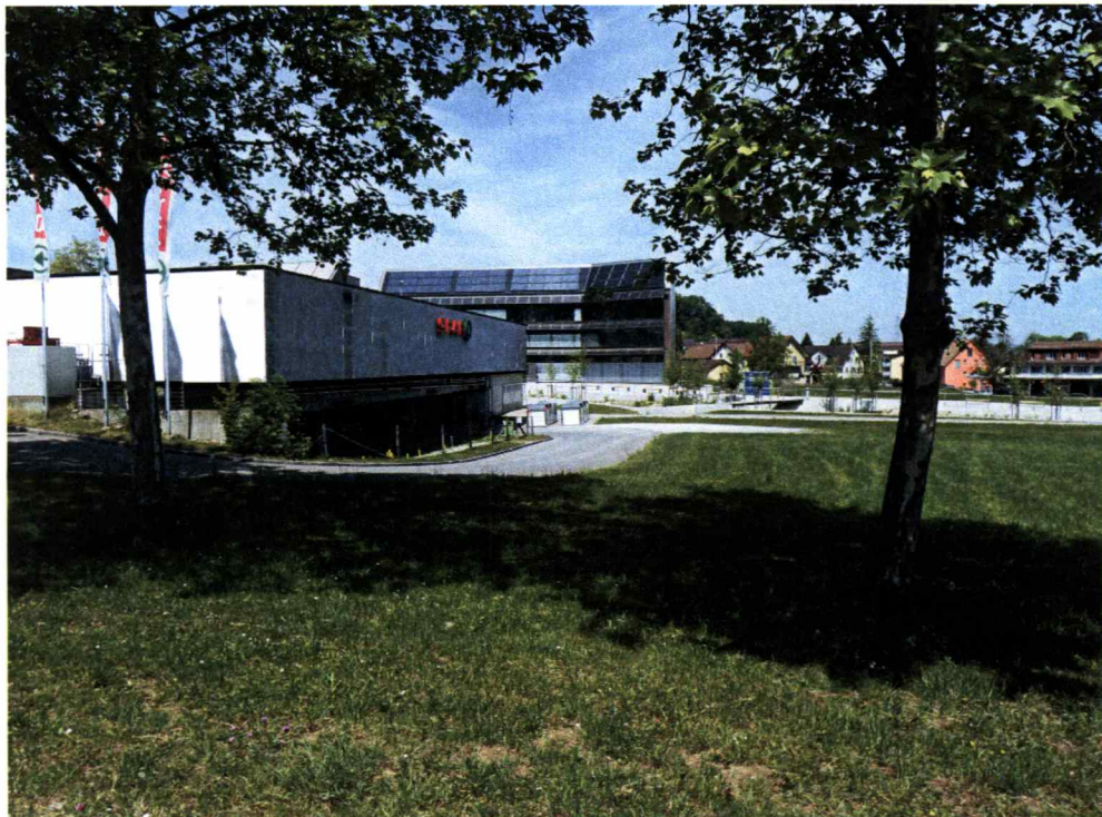
Die bestehende Tiefgarage mit dem darüberliegenden Ladenprovisorium
