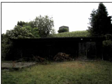
Die Baracke innerhalb des Waldabstandes hat Bestandesgarantie.
