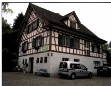
Das Gebäude im Baubereich E hat zwei Wohnungen.
