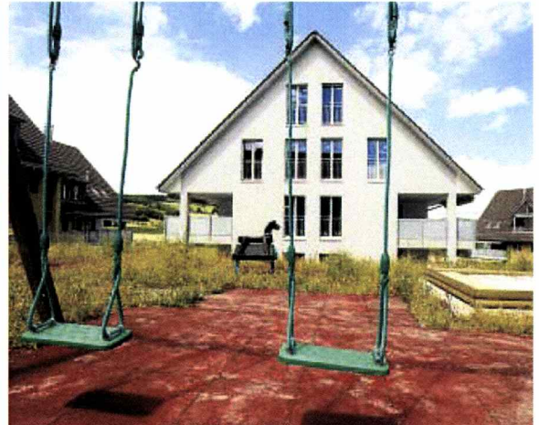
Abb. 2b: Beispiel von Gebäude mit zwei Dachgeschossen aus Bonstetten ZH, Quelle: NZZ vom 23. Juli 2008
