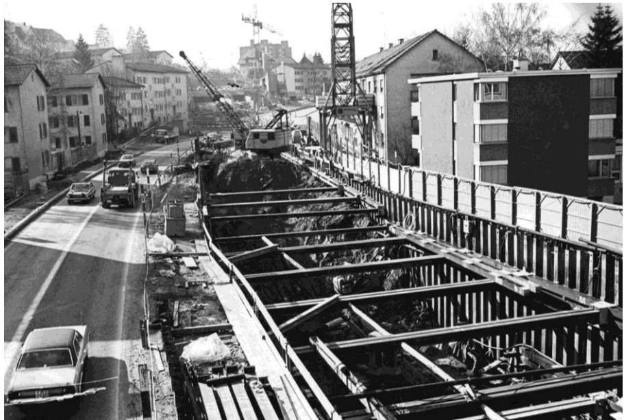
Abb. 16: Bau der SN1.4.4 1977 (Bild BAZ)
