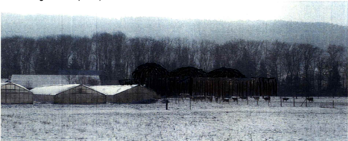
Abb. 6: Erweiterung Biogasanlage, Sicht von Norden im Winter
