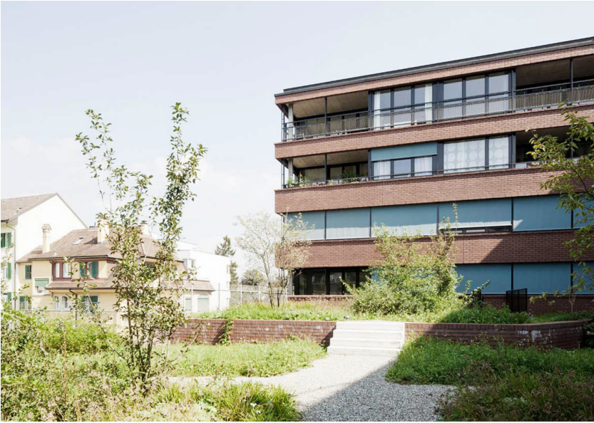
Wohn- und Geschäftshaus Parkside Schlieren, Weber Brunner Architekten
