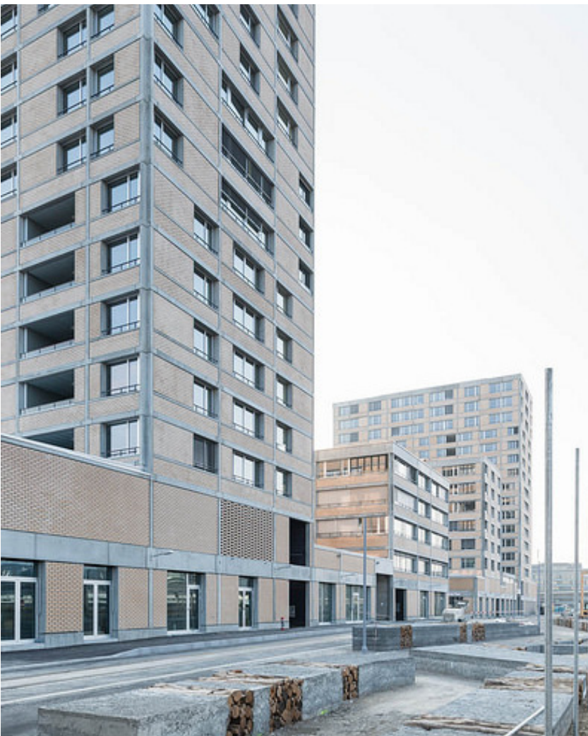
Letzibach Teilareal C, Adrian Streich Architekten mit Loeliger Strub Architektur, vorgefertigte Betonrahmen mit Klinkerausfachung
