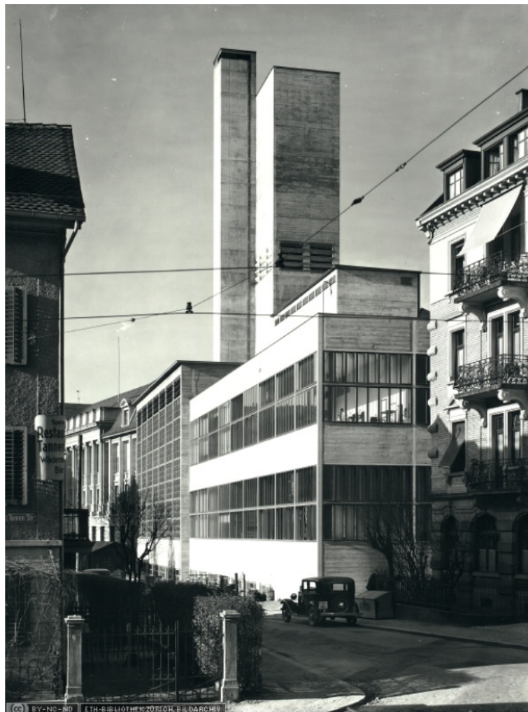
Abbildung 17: Textillabor und Fernheizkraftwerk mit Kühlturm und Hochkamin: Ansicht von Südosten mit Blick auf Clausiusstrasse (ETH-Bibliothek)
