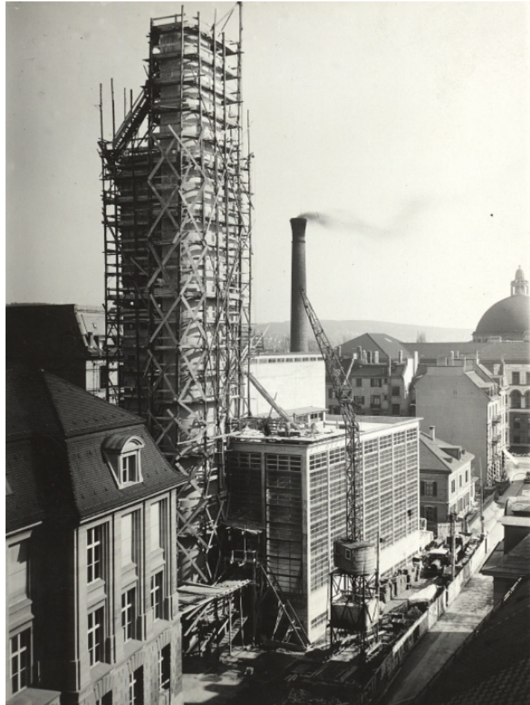
Abbildung 13: Baustelle Fernheizkraftwerk: Ansicht von Nordwesten mit Blick gegen ETH-Hauptgebäude (ETH-Bibliothek)
