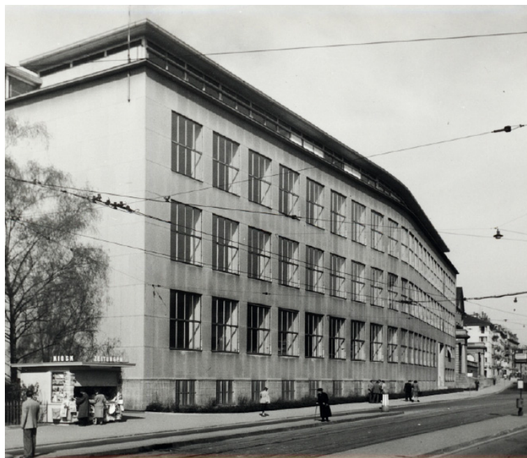
Abbildung 18: Lehrgebäude mit Dachaufstockung: Ansicht aus der Universitätsstrasse mit Blick gegen Sonneggstrasse (ETH-Bibliothek)
