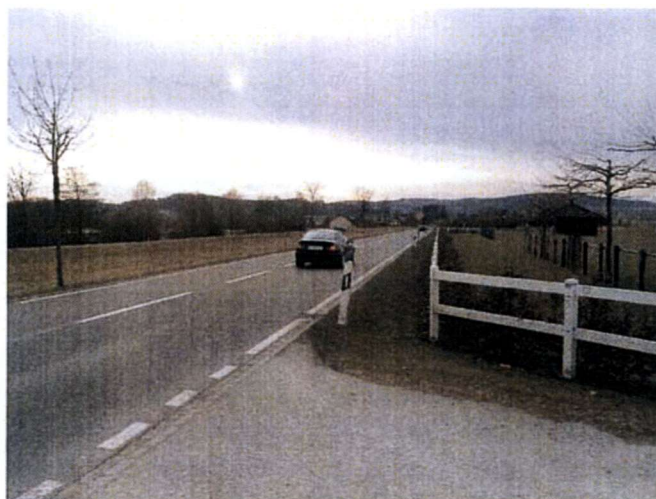
Abb.11: Parkplatz P2 Ausfahrt Rietstrasse Sicht in Richtung Neftenbach
