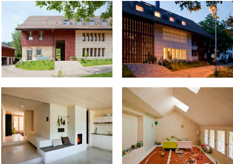
Abb. 4 bis 5: Beispiel zeitgemässer Umnutzung eines Ökonomietraktes, Bauma ZH. Scheune Hörnen, Horisberger Wagen Architekten GmbH, Bilder: Beat Bühler, Zürich / Quelle: http://www.das-ideale-heim.ch , 15103_Bauma_dS_150324_ScheuneHörnen
