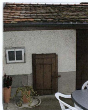
Waschhaus mit Schweinestall.
