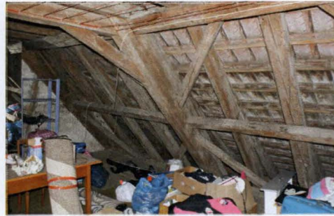
Links oben: Korridor DG
