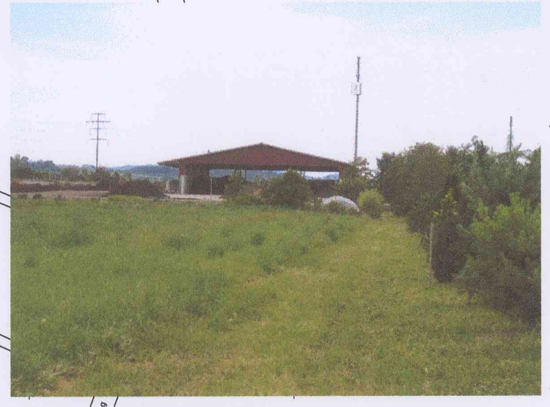
Lagerhalle und Kompostierplatz
