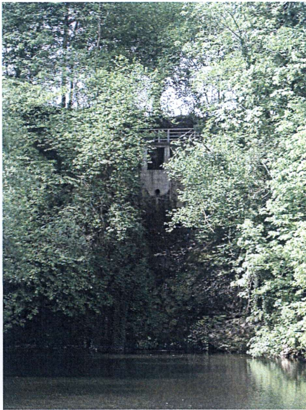
Abb. 9 ,Wasserfall', Überlaufbauwerk des Oberwasserkanals ,Wasserfall'.
