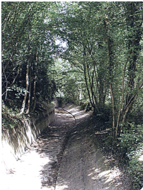
Abb. 10 Oberwasserkanals. ohne Wasser, Sanierung Winter 2001
