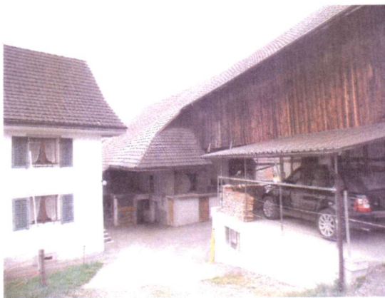
Hocheinfahrt von Süden mit der unteren Zufahrt
