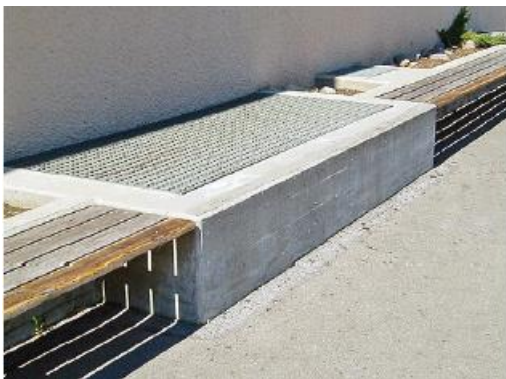
Abbildung 6: Beispiel eines erhöhten Lüftungsschachtes (Bild: GVZ)
