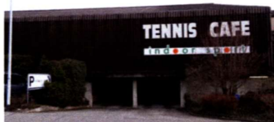
Einfahrt bestehende Einstellhalle
