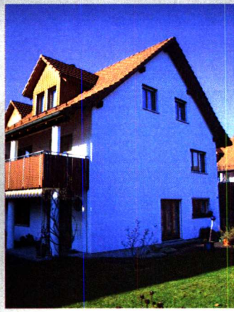
Satteldachgebäude mit 2 Voll- und 2 Dachgeschossen
