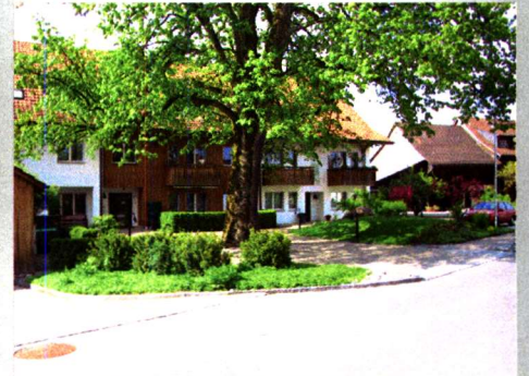
unten: Gebäude an der Sagenrainstrasse in der Quartiererhaltungszone
