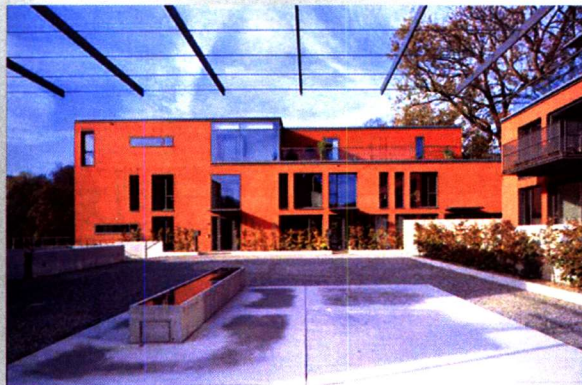
Die um einen Hof angeordnete Gebäudegruppe (Büro B Architekten, Bern)
