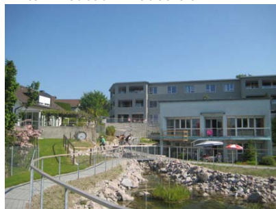
Hinten: Neubau in Baubereich 1
