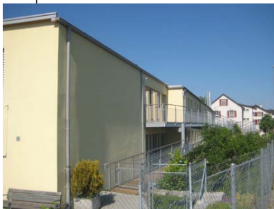
Rampe nördlich von Baubereich 3
