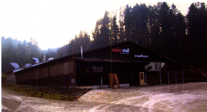
Die als Betriebsgebäude umgenutzte Reithalle mit Umbau
