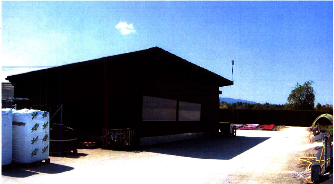
Bestehendes Betriebsgebäude, Foto M. Wiesendanger AG vom Mai 2008
