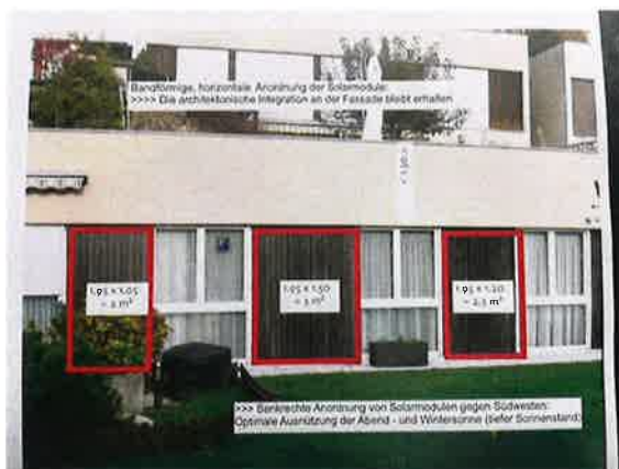
Abbildung 11: Konzept Solarmodule an Fassade
