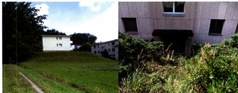
Abb. Nr. 19 links bestehende Aufschüttung, rechts Abgrabung für Hauseingang (Fotos September 2013)
