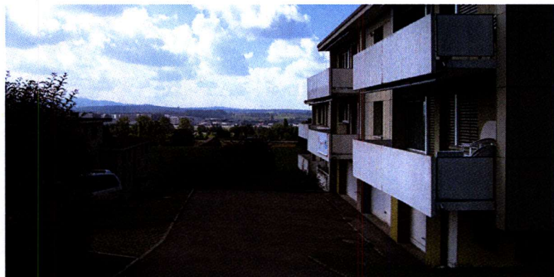
Abb. Nr. 14 heutige Bebauung mit Zugang und Garagen
