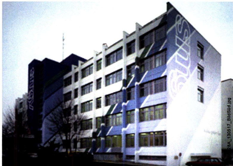
Abb. 1: Dienstleistungszentrum SMGV. Quelle: agps architecture
