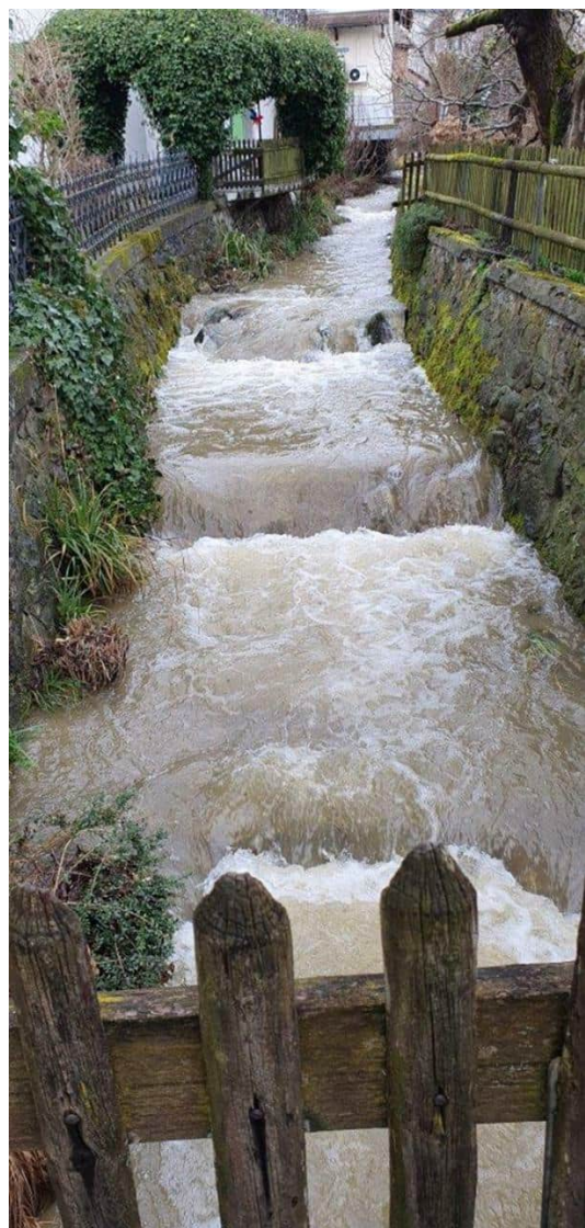
Dorfbach bachaufwärts Brücke bei Zwillikerstrasse 7 (© Gemeinde Hedingen, 2025)
