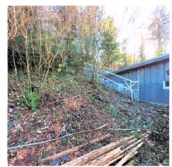
Ostfassade Böschung jetzt Gebäude +/- Originalbestand
