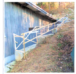
Westfassade Böschung seitlich Gebäude +/- Originalbestand
