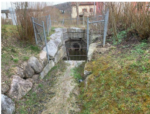
(c) Ju_01 – Ju_02: Eindolung Bauwerk
