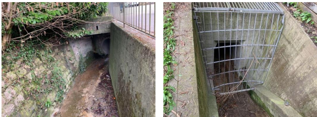
Abbildung 12 Foto links: Blick bachaufwärts zum Auslauf Durchlass Waldistrasse; Foto rechts: Blick bachabwärts zum Einlauf Durchlass Kreuzung Albisstrasse – Finsterrütistrasse
