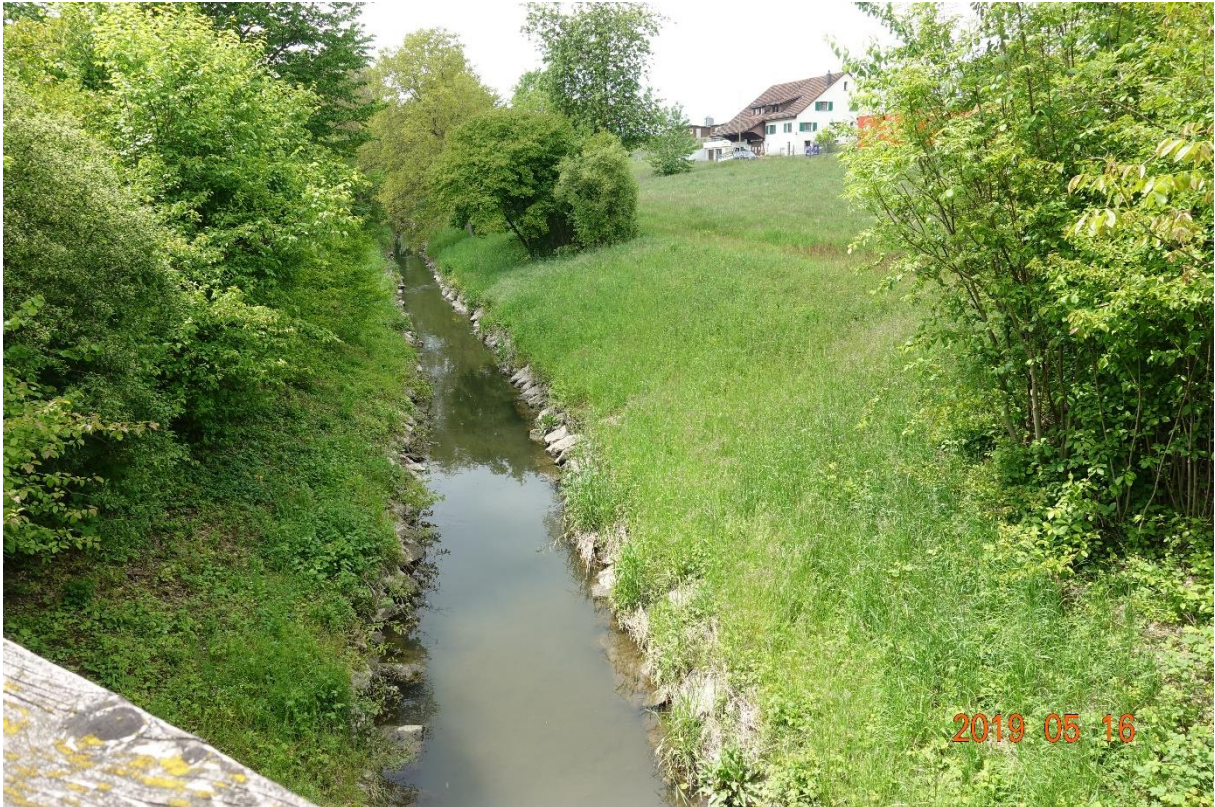
Abbildung 25: Foto vom Abschnitt 0.21 - 0.00. Blick gegen die Fließrichtung, aus der kleinen Brücke. Mittlere Sohlenbreite 2.5 m. (Eigene Aufnahme vom 16.5.2019).
