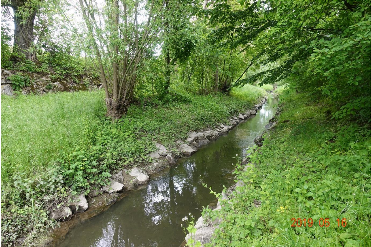
Abbildung 24: Foto vom Abschnitt 0.39 - 0.21. Blick in Fliessrichtung. Mittlere Sohlenbreite 2.5 m. (Eigene Aufnahme vom 16.5.2019).
