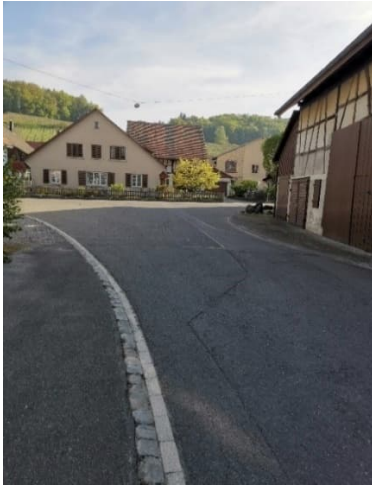
Abbildung 33: Abschnitt "Breitenrietgraben IV" Kreuzung Dorfstrasse und Schulhausstrasse oberhalb der Eindolung, 29.04.2022
