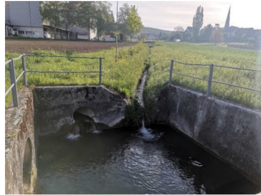
Abbildung 20: Ausfluss Trüllikerbach ausserhalb des Abschnittes "Trüllikerbach III", 29.04.2022
