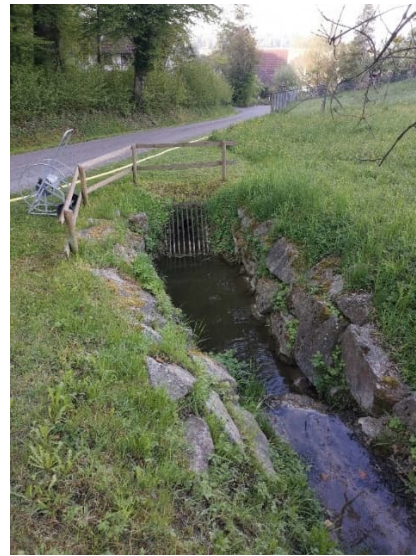
Abbildung 31: Abschnitt "Breitenrietgraben III" Einfluss in die Eindolung, 29.04.2022
