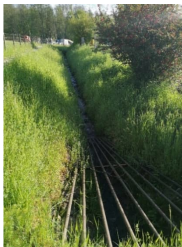
Abbildung 37: Abschnitt "Tellengraben I" Sicht von Süden, 29.04.2022
