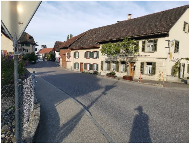
Abbildung 16: Abschnitt "Trüllikerbach II" Andelfingerstrasse oberhalb der Eindolung, 29.04.2022
