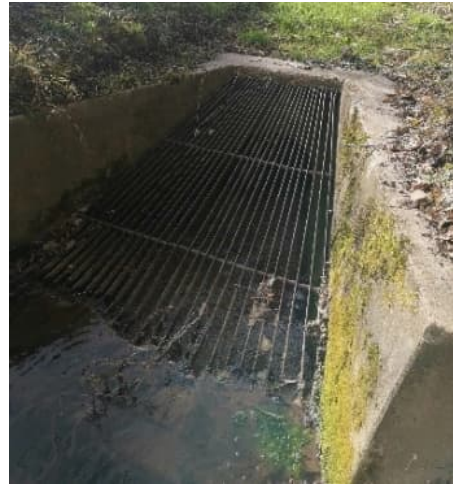
Abbildung 16: Abschnitt "Dorfbach II", Einlauf, Eindolung 06.02.2023
