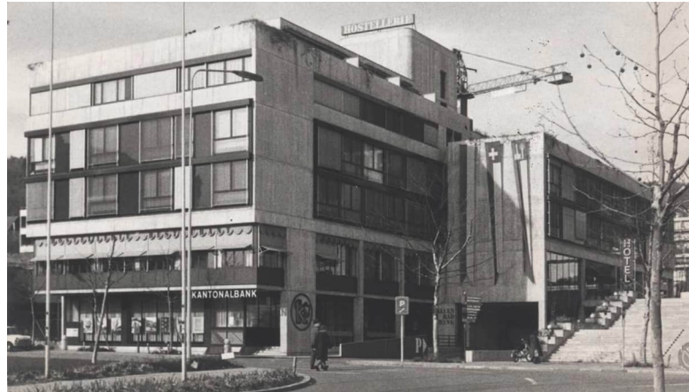
Abb. 16: Ansicht Hotel, Foto 1977
