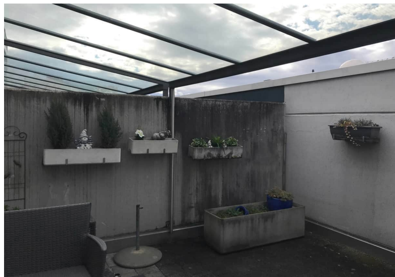
Abb. 24: Trennendes Element im Baubereich J2 (Foto: Choffat + Filipaj Architekten GmbH)
