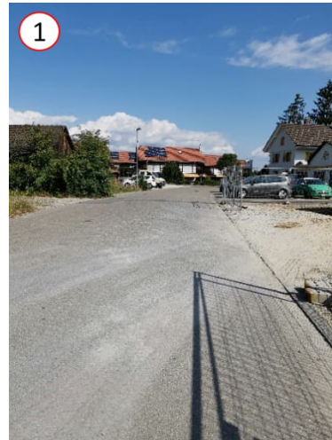
Abbildung 17: Abschnitt "Dorfbach III", Alte Andelfingerstrasse, Strassenraum oberhalb der Eindolung, 27.07.2022
