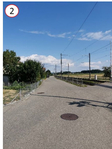
Abbildung 19 Abschnitt "Dorfbach III", Landwiesstrasse, Strassenraum oberhalb der Eindolung, 27.07.2022
