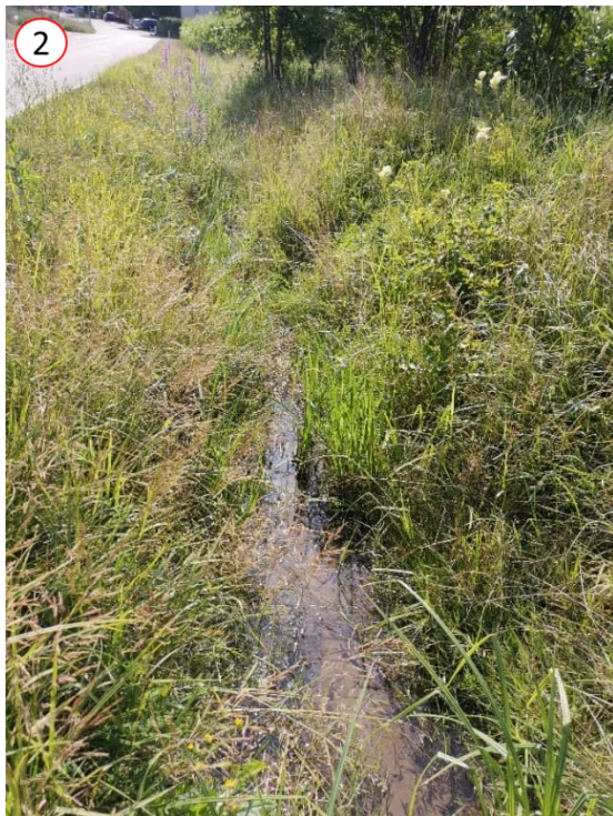
Abbildung 24: Verlauf Dorfbach entlang "Rietstrasse", HWE befindet sich eingedolt rechts davon., 27.07.2022
