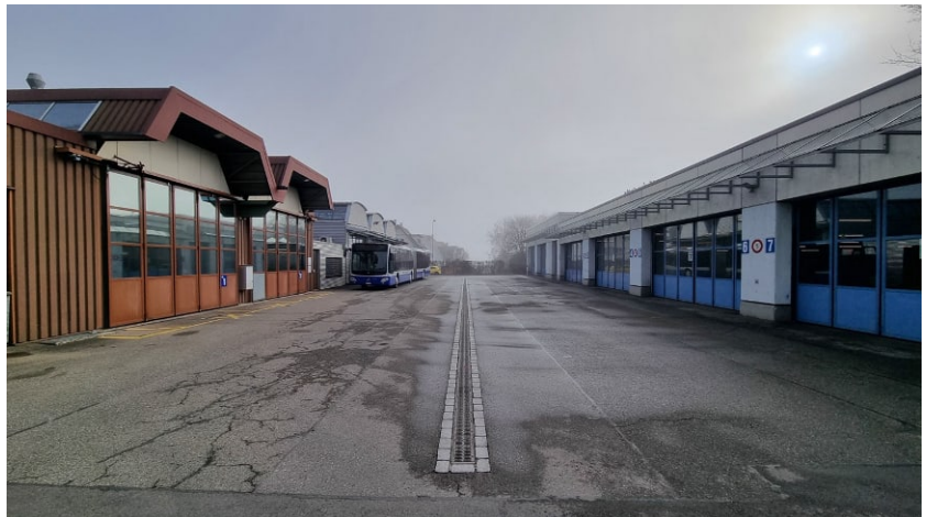
Werkstattgebäude links und Einstellhalle rechts, Blick nach Osten
