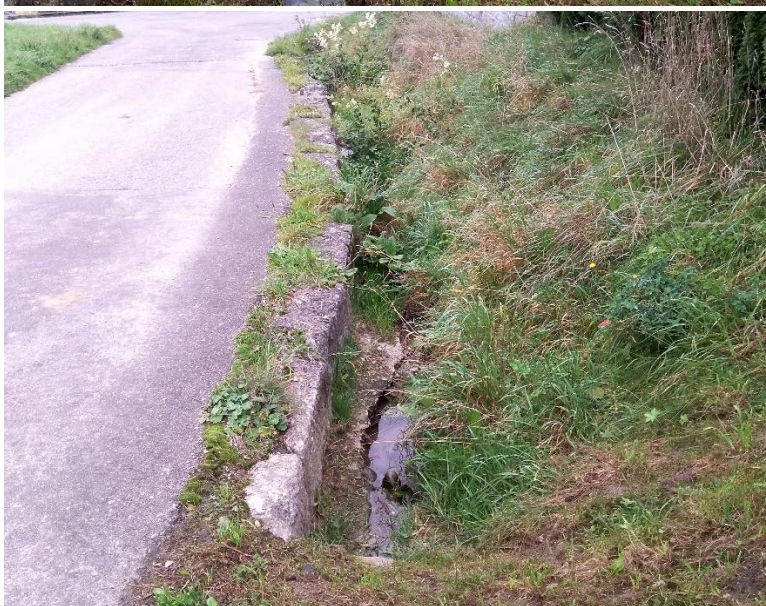
1004_01 Unterer Abschnitt In Fliessrichtung ab Durchlass Quartierstrasse
