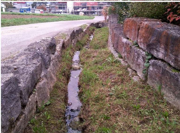
1004_01 Oberer Abschnitt In Fliessrichtung bis Durchlass Quartierstrasse
