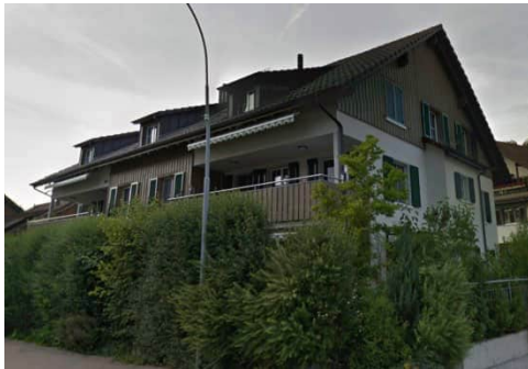
Wohngebäude Pfungenerstrasse 23 Vers.-Nr. 742
