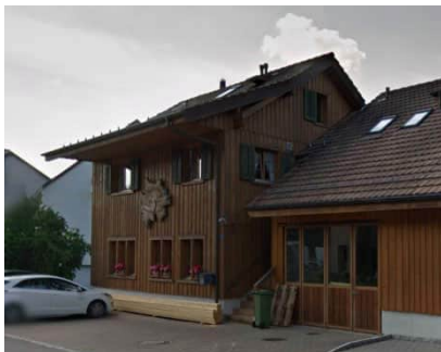
Wohngebäude Pfungenerstrasse 21 Vers.-Nr. 98
