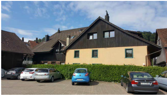
Wohnhaus Pfungenerstrasse 1 Haldenweg 4 - 8 Vers.-Nr. 434
