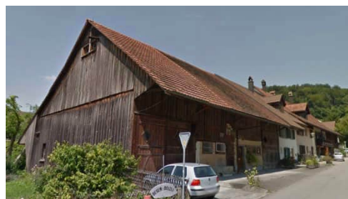
Wohnhaus Haldenweg 1 - 7 Vers.-Nr. 446 + 448
