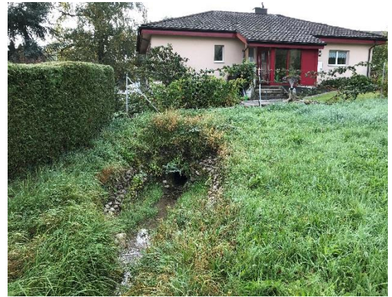
Abbildung 5: Auslaufbereich am Chilenstig (Blick gegen Fließrichtung)
