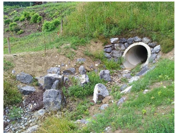
Abbildung 22: Gleiches Beispiel, ein Jahr nach Realisierung (Blick gegen Fließrichtung. Quelle: HOLINGER AG)
