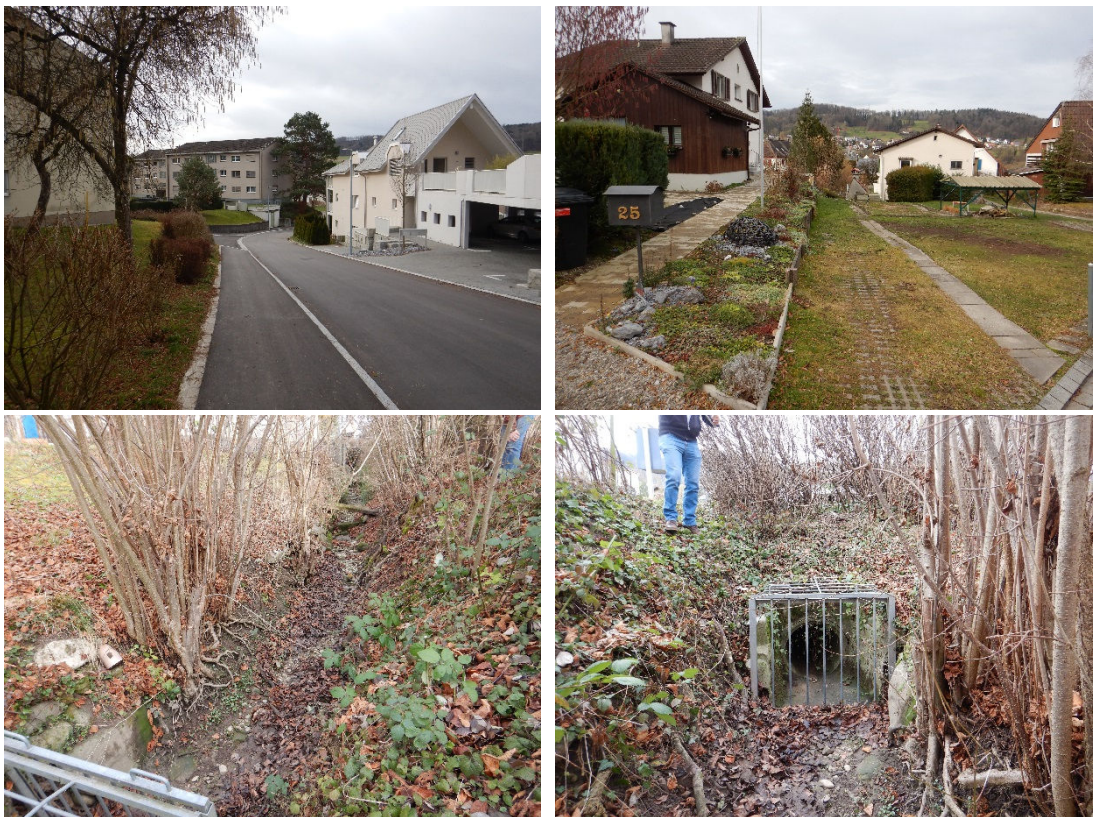
Abbildung 23: Verlauf des eingedolten Abschnitts unter dem Riedhalden (oben links) und zwischen den Gebäuden unterhalb der Breitestrasse (oben rechts). Der offene Abschnitt ohne Wasser (unten links) vor dem Rechen des eingedolten Abschnitts unterhalb des Projektperimeters (unten rechts).
