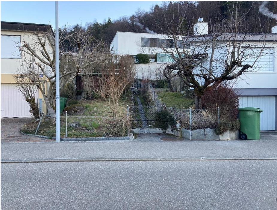
Abbildung 18: Aufnahme Standort 11, Abschnitt D4
