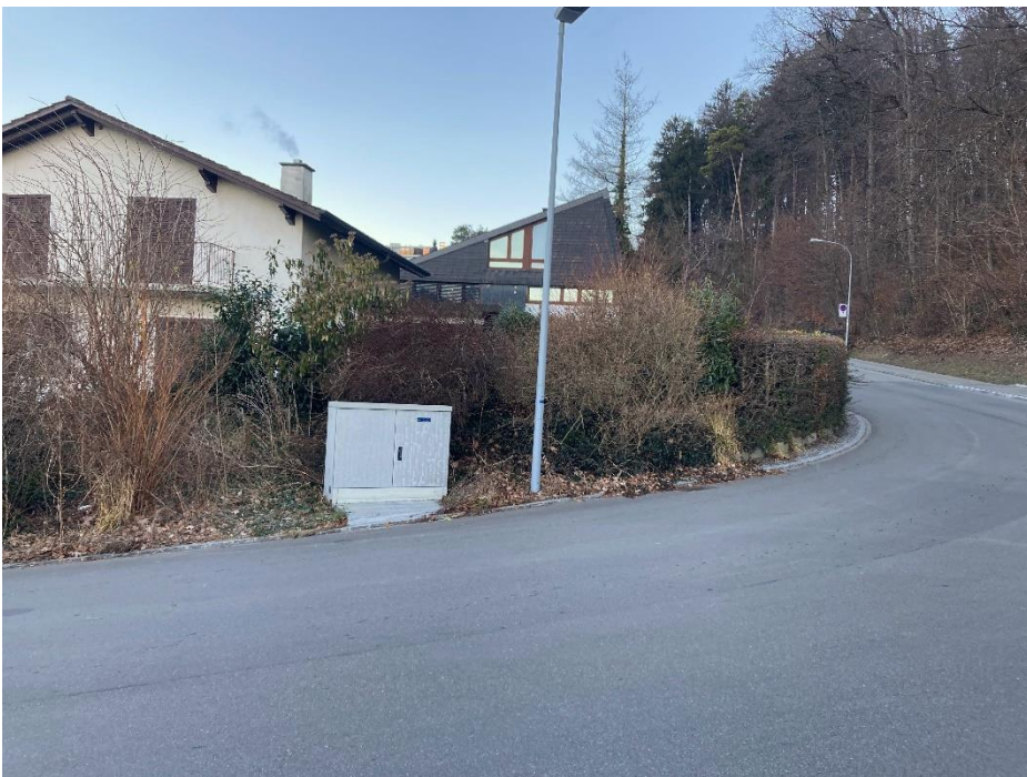
Abbildung 13: Aufnahme Standort 8, Abschnitt D1
